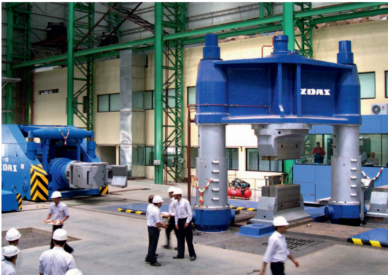
Skutečná zástavba kovacího souboru od společnosti ŽDAS
